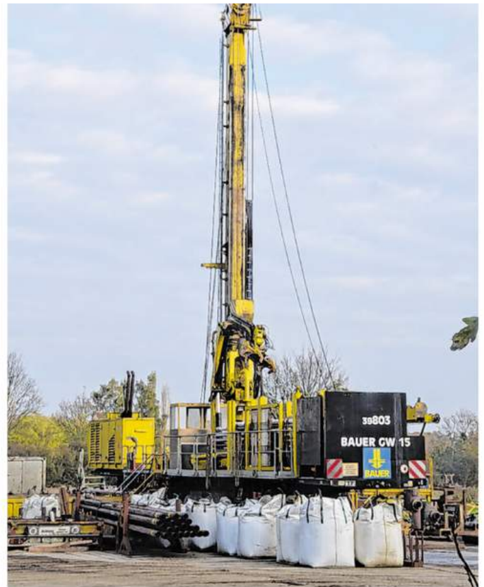
In zwei Wochen soll die Bohrung an Gut Stepprath eine Tiefe von rund 400 Metern erreicht haben. Foto: Abels
