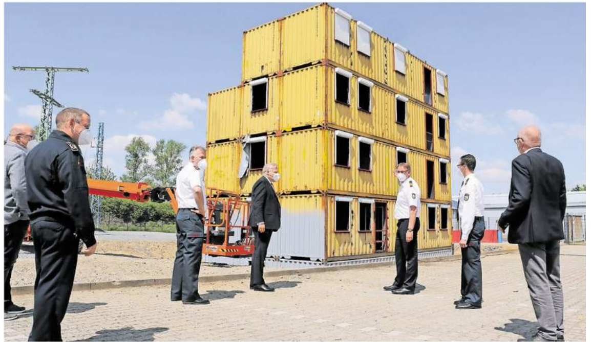
In gestapelten Seecontainern sollen Führungskräfte der Feuerwehr ab Ende Juni trainieren können, wie sie bei einem Brand in einem Mehrfamilienhaus handeln müssen. Vertreter vom Kreis Düren und des Instituts der Feuerwehr in NRW schauten sich in dieser Woche auf dem Areal in Stockheim um. FOTOS: PATRICK NOWICKI
