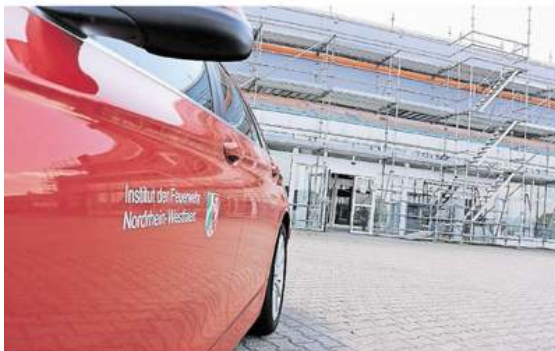
Der ehemalige Baumarkt im Gewerbegebiet Kreuzau-Stockheim wird zum Übungszentrum des Instituts der Feuerwehr umgebaut.
