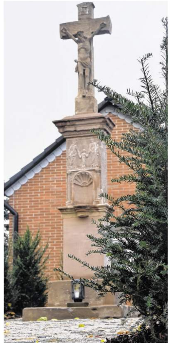
Das sanierte Dorfkreuz wird am morgigen Freitag im Rahmen einer Feierstunde eingeweiht. Die STIG hat 11 000 Euro in das Projekt investiert.
