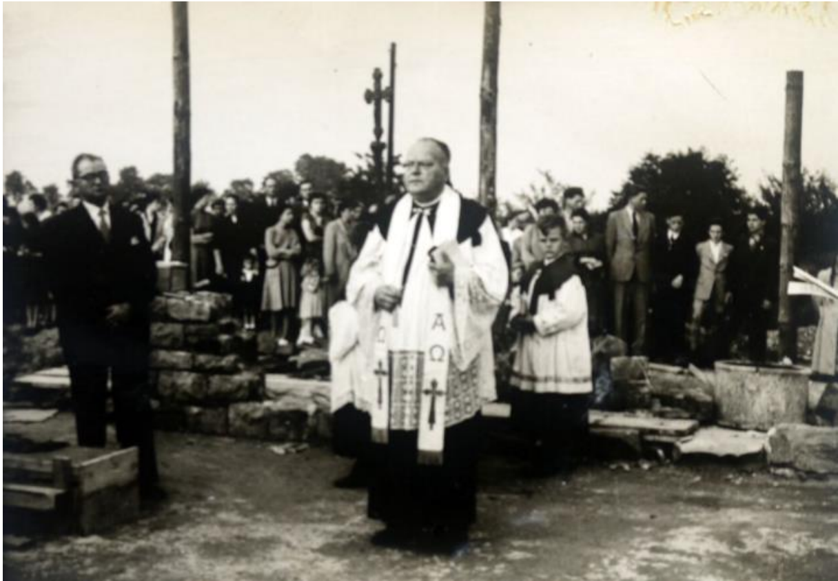
Grundsteinlegung 1954 Grundschule alter Teil
